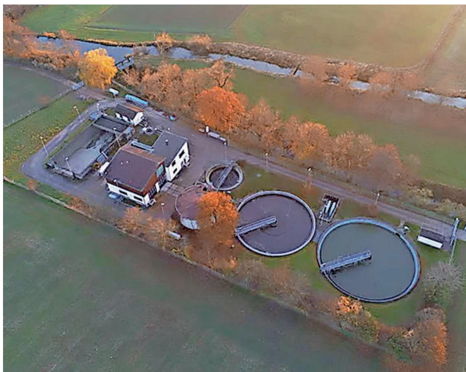
Kläranlage Westhausen – 6,8 Mio. Euro Landesförderung für die Erweiterung
